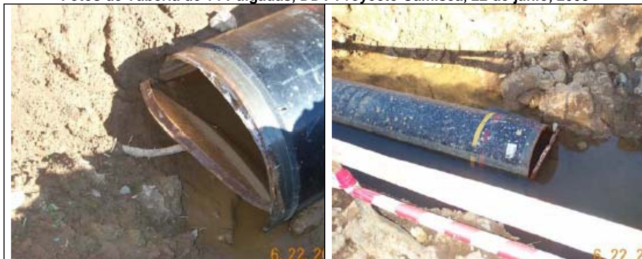
Fotos de Tubería de 14 Pulgadas, DDV Proyecto Camisea, 22 de junio, 2003
