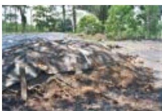
Foto 1. Rípiro de perforación en el pozo Palo Azul B
